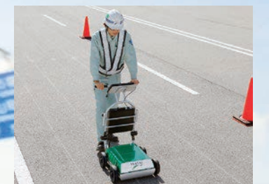
現地点検状況
