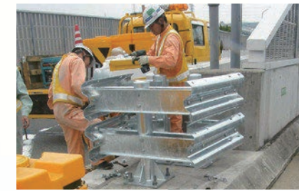
ガードレール補修
