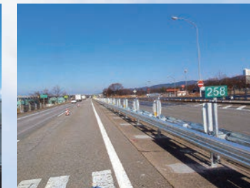
北陸道 富山防護柵工事
