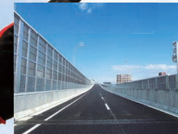
県道高速名古屋新宝線 七番工区遮音壁設置工事
