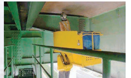
コンクリート床版の点検
