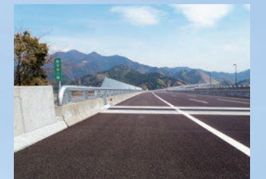
新東名 静岡東 鋼製高欄、落下物防止柵工事
